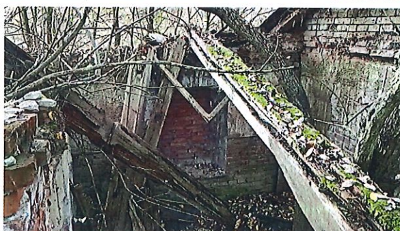
Obrázek 7, 8, 9, 10, 11, 12 – Pohled na interiér stávající budovy č.p. 20 v obci Bukovany – jihovýchodní část se zřícenými nosnými konstrukcemi
