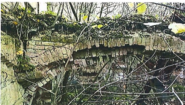
Obrázek 13, 14, 15, 16, 17, 18, 19 – Pohled na interiér stávající budovy č.p. 20 v obci Bukovany – středová a severozápadní část se zřícenými nosnými konstrukcemi
