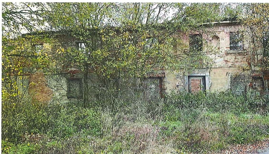
Obrázek 6 – Pohled na jihozápadní průčelí stávající budovy č.p. 20 v obci Bukovany od jihozápadu – zřícená konstrukce krovu, zřícená stropní konstrukce nad 2.n.p., nad 1.n.p. a částečně zřícené obvodové nosné stěny ve 2.n.p. u jižního nároží
