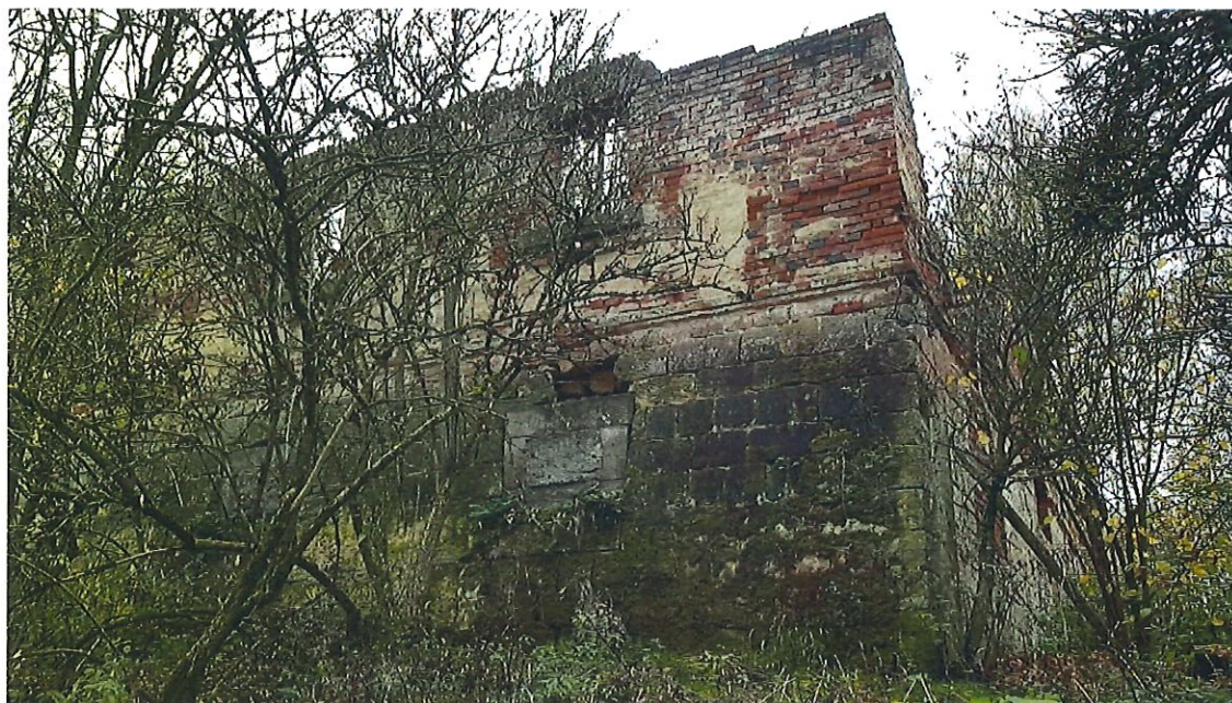
Obrázek 5 – Pohled na severovýchodní průčelí stávající budovy č.p. 20 v obci Bukovany od severovýchodu – zřícená konstrukce krovu, zřícená stropní konstrukce nad 2.n.p., nad 1.n.p. a částečně zřícené obvodové nosné stěny ve 2.n.p.
