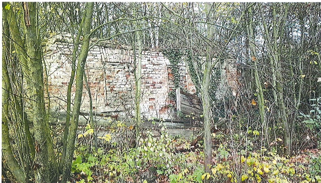
Obrázek 3 – Pohled na jihovýchodní štít stávající budovy č.p. 20 v obci Bukovany od jihovýchodu – zřícená konstrukce krovu, zřícená stropní konstrukce nad 2.n.p., nad 1.n.p. a zřícené obvodové nosné stěny ve 2.n.p.
