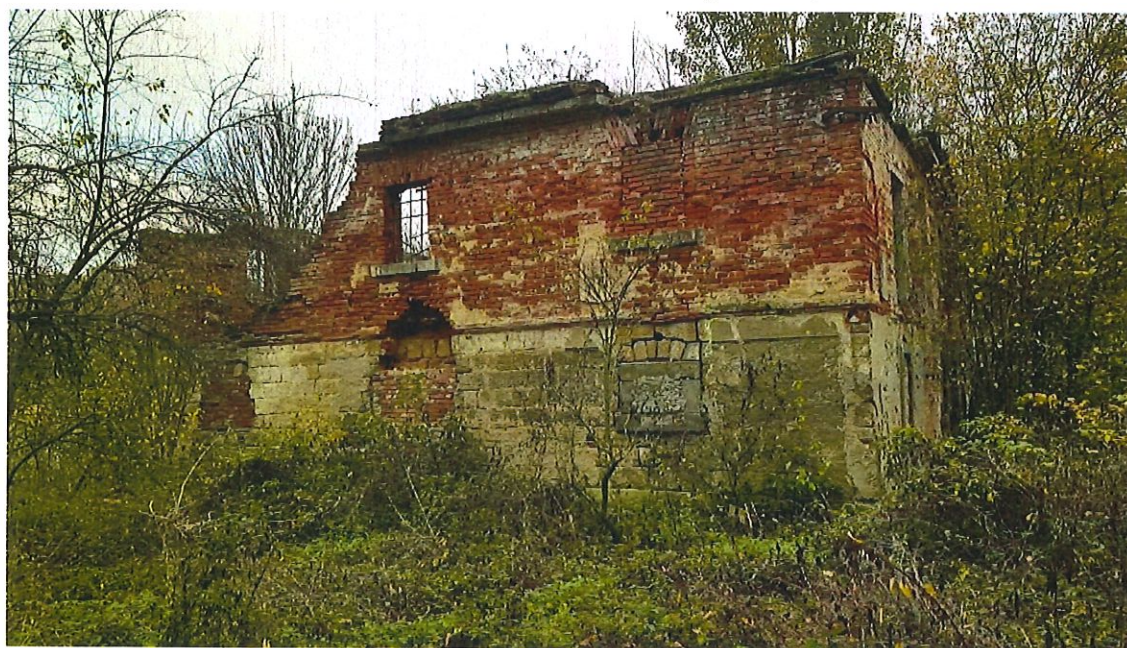
Obrázek 4 – Pohled na severozápadní štít stávající budovy č.p. 20 v obci Bukovany od severozápadu – zřícená konstrukce krovu, zřícená stropní konstrukce nad 2.n.p., nad 1.n.p. a částečně zřícené obvodové nosné stěny ve 2.n.p.
